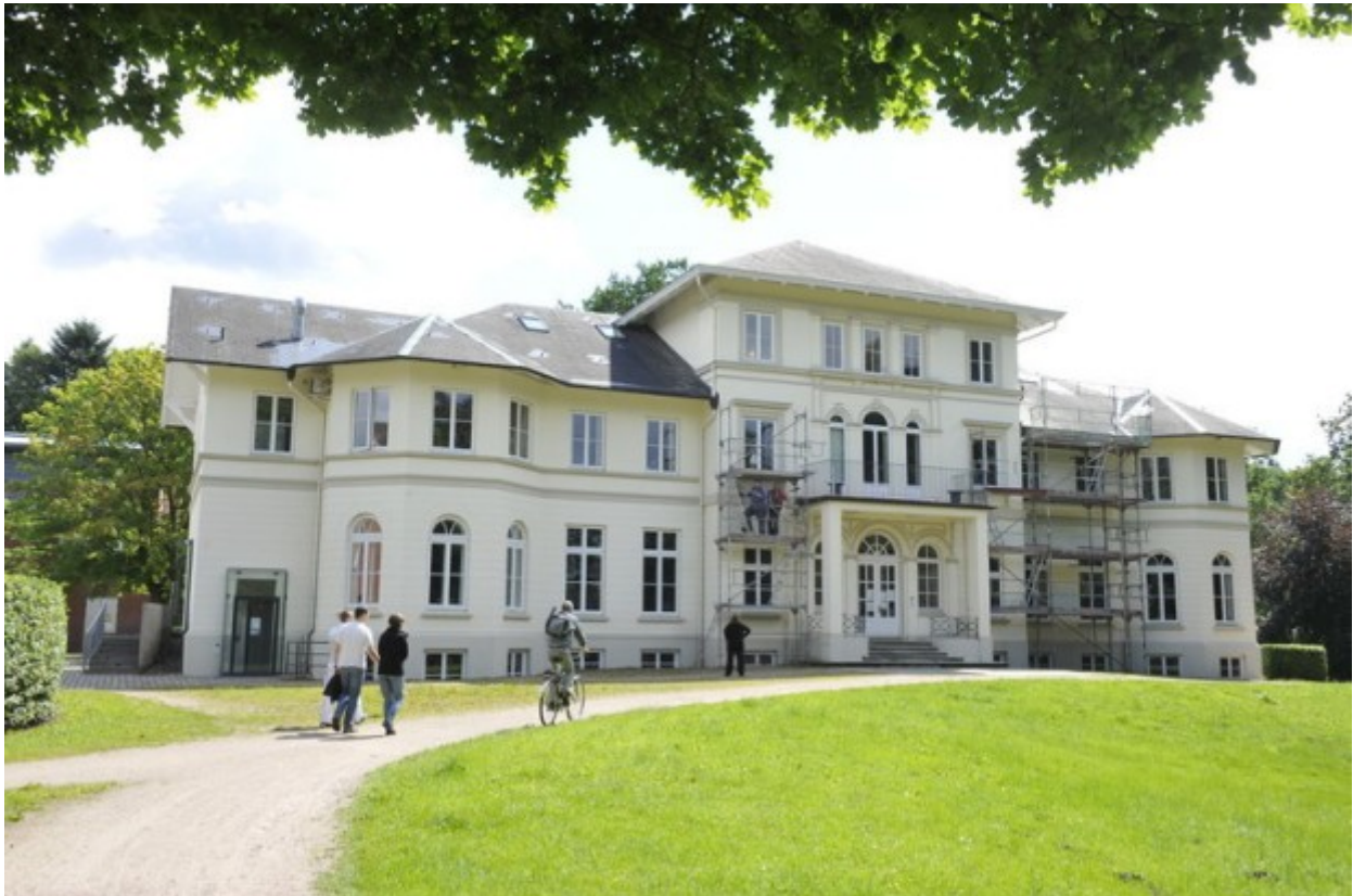
Das Schloss Berne, Berner Allee 31a, wurde 1880 erbaut
